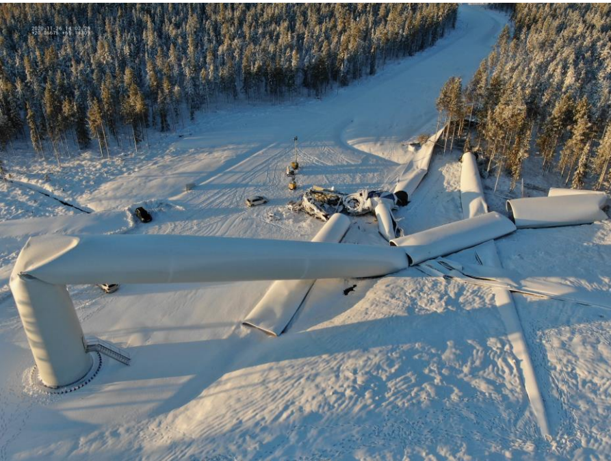
Det havererade verket på Aldermyrberget.
